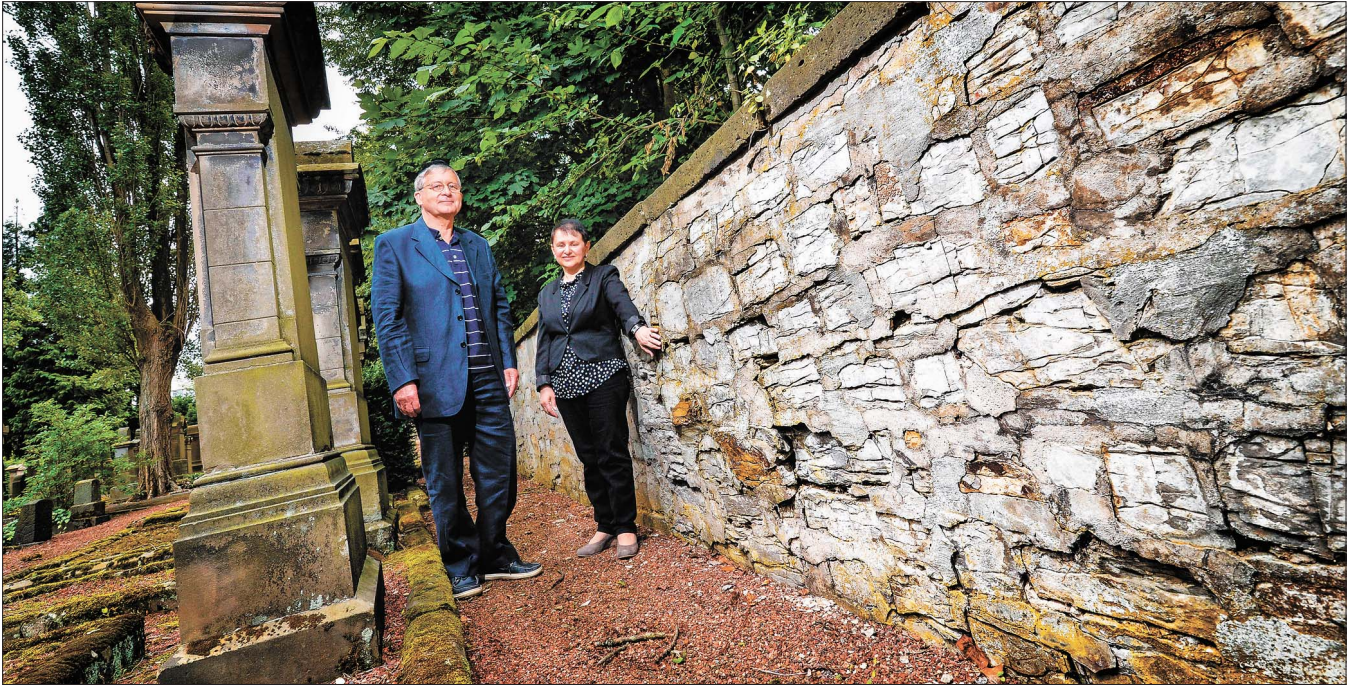
Tanja Rubens, Vorsitzende der jüdischen Kultusgemeinde, und Bürgerstiftungs-Chef Hans Behringer stehen vor der alten Mauer des 1883 errichteten jüdischen Friedhofes. 70 Quadratmeter wird der Borchener Bauunternehmer Johannes-Dieter Huneke restaurieren. Den Löwenanteil der Kosten übernimmt die Paderborner Bürgerstiftung.
